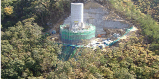
기존의 공사 경험을 바탕으로 성풍의 발전된 역량을 한 단계 향상시킨 것은 물론이고, 환경 친화적 공사 사례로 호평을 받은 신와~성북간 등용터널 공사 현장
