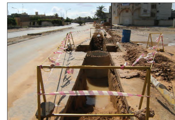
리비아 Al Khoms 도로기반 시설 공사
