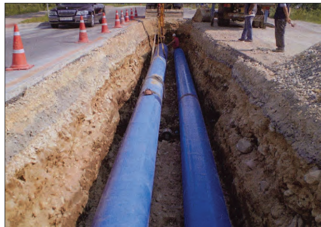
상하수도 설비 공사
