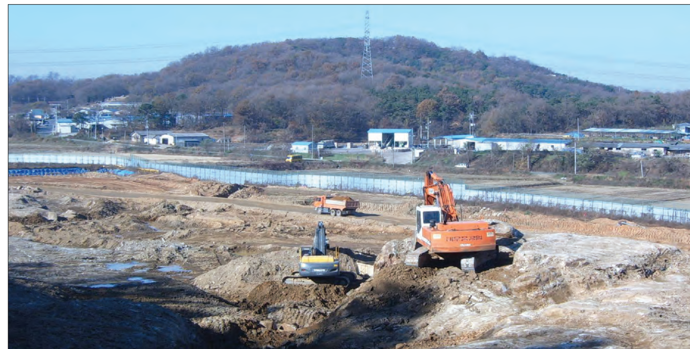
김포 장기지구 택지개발 공사
