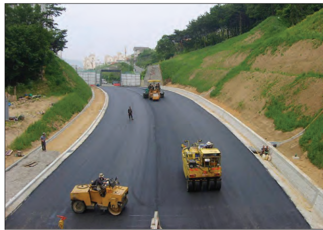
도로 개설 공사
