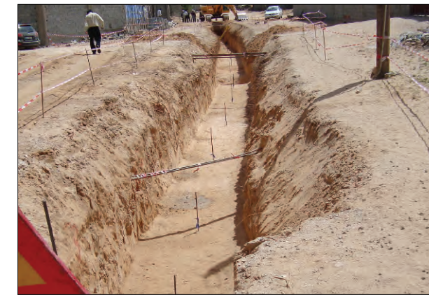
리비아 Zliten 도로기반 시설 공사
